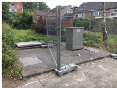
vergelijkbare opstelling als op schoolplein basisschool Lunetten (CPE onderzoek)
